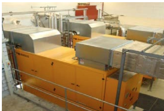
Blockheizkraftwerke Gasaufbereitung
