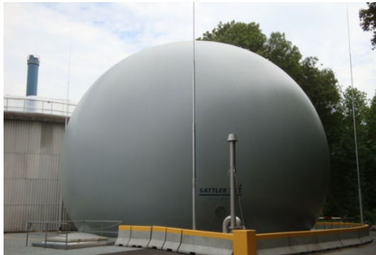
Doppelmembrangasspeicher Gasspeicher
