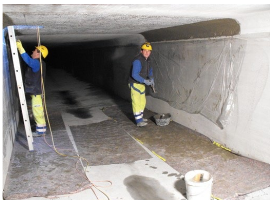
Sanierungsarbeiten fertiger Kanal
