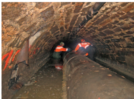
Gemauerter Grendelkanal im Einstau Verrutschte Steine in Kanaldecke
