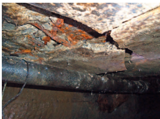
Beschädigungen Kanaldecke Provisorische Abstützung
