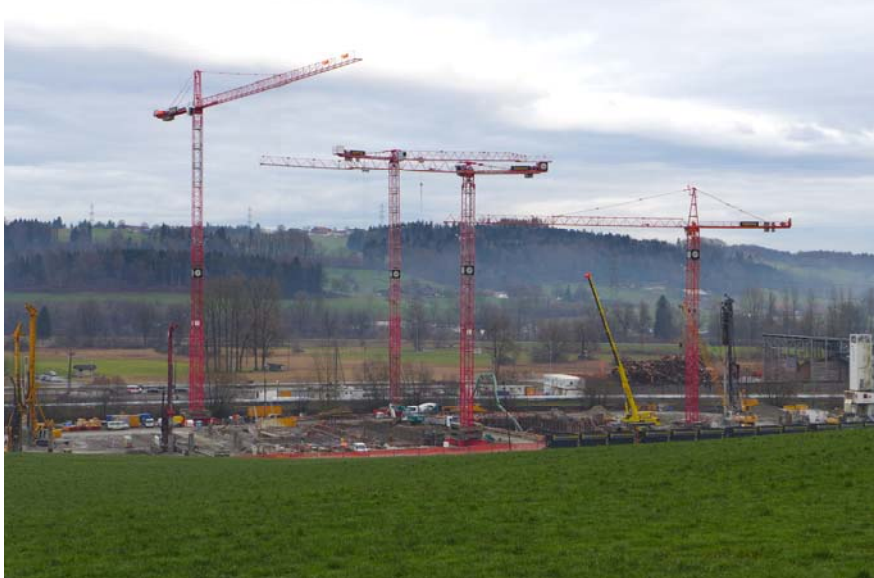
Baustelle Renergia zu Jahresbeginn 2013
