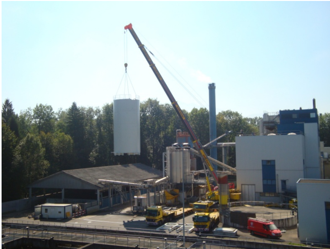
Setzen des zweiten Schlammsilos
