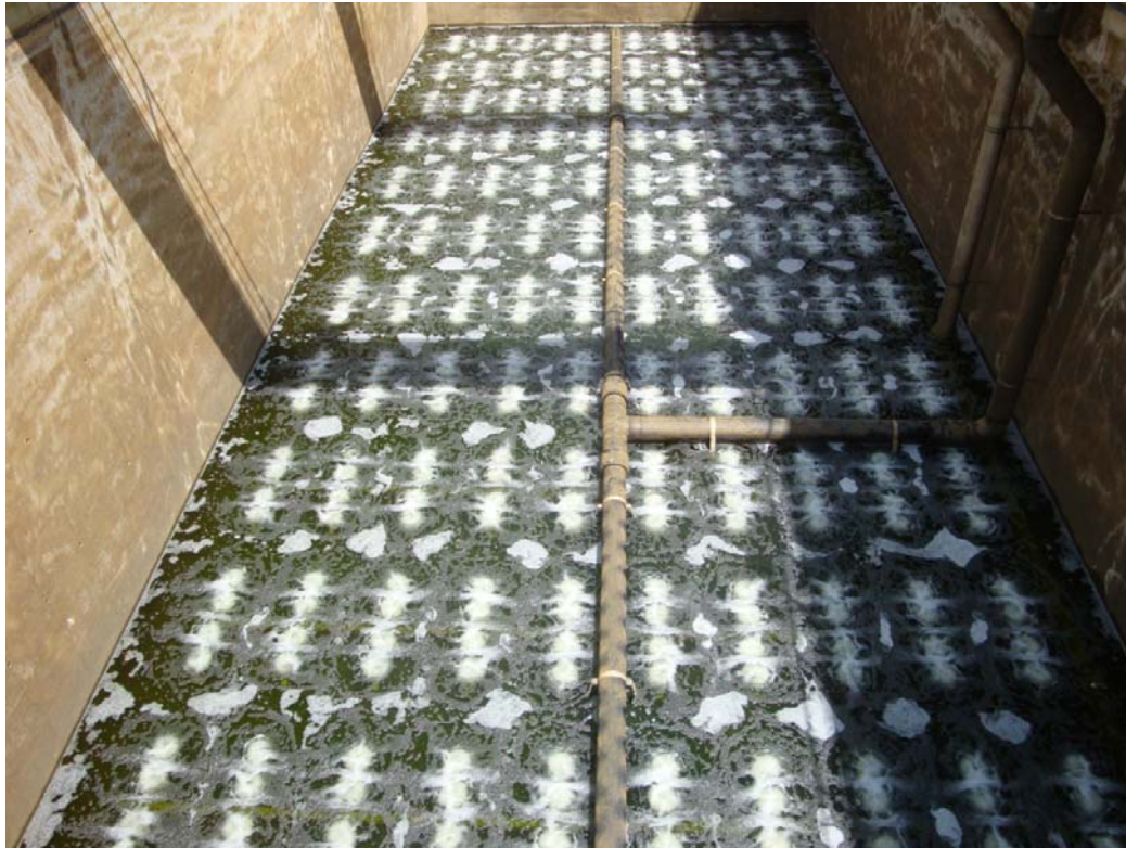
Erfolgreicher Test des Blasenbilds nach dem Ersatz der Belüfter im leicht gefüllten Biologieblock 2.
