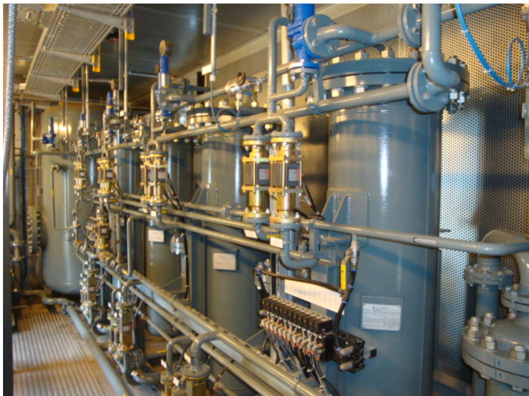
Aktivkohle-Adsorber der Gasaufbereitung
