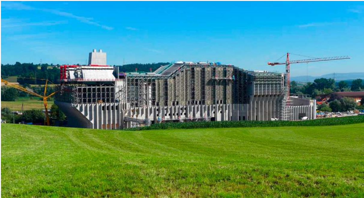
Renergia: die modernste KVA der Schweiz (Baustand Sommer 2014)
