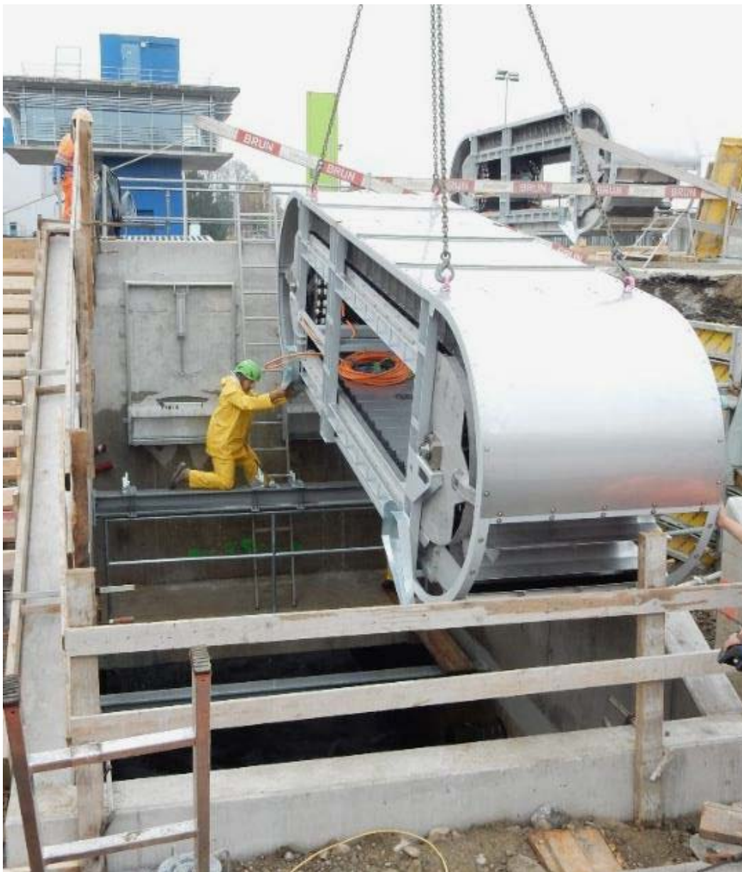
Einbau Ablaufturbinen ARA (Bild REAL)
