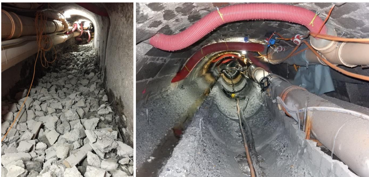
Bild links: Ausbruch Kanalsohle im Abschnitt Löwengraben. Bild rechts Kanalsanierung im Abschnitt Grendel. (Bilder REAL)
