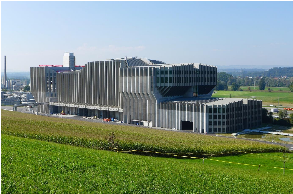
Die neue Verbrennungsanlage der Renergia Zentralschweiz AG in Perlen.
