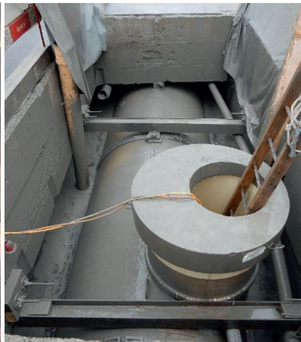
GFK-Rohr mit Dämmer umgossen
