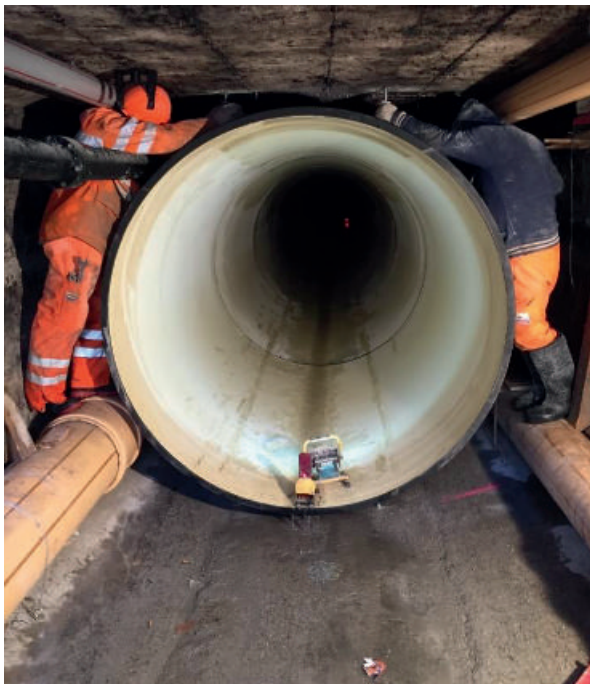
Einzug der GFK-Rohre
