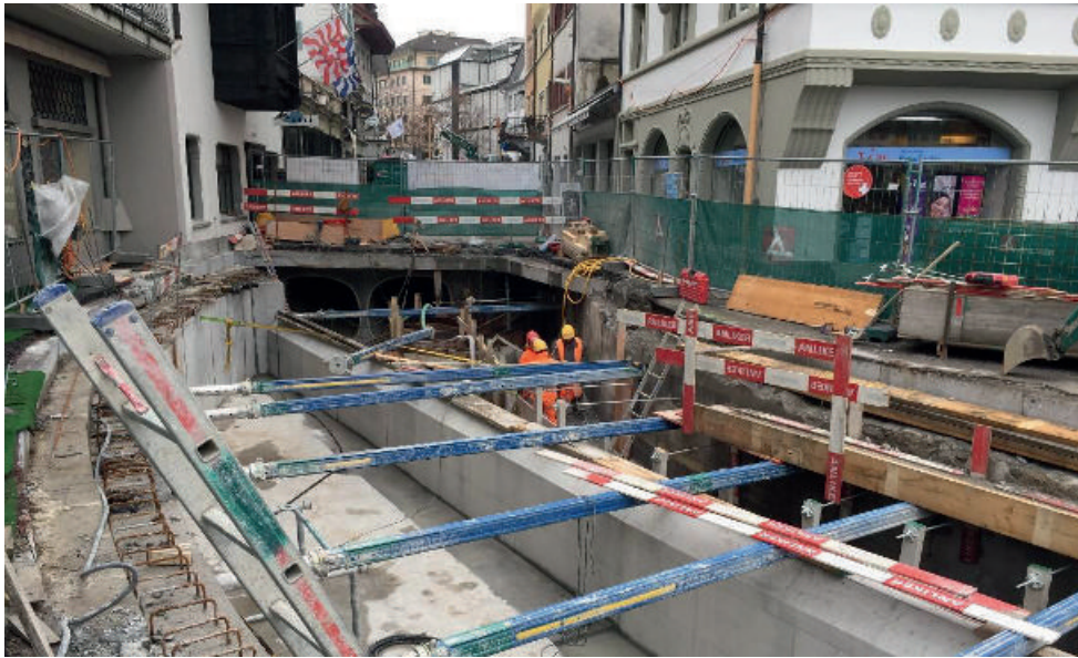
Arbeiten am Regenauslass in die Reuss beim Reusswehr. In der Mitte ist die neue Überlaufkante sichtbar.
