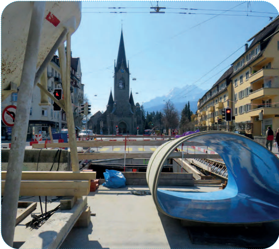
Sanierungsarbeiten am Krienbachkanal Abschnitt Paulus- bis Pilatusplatz
