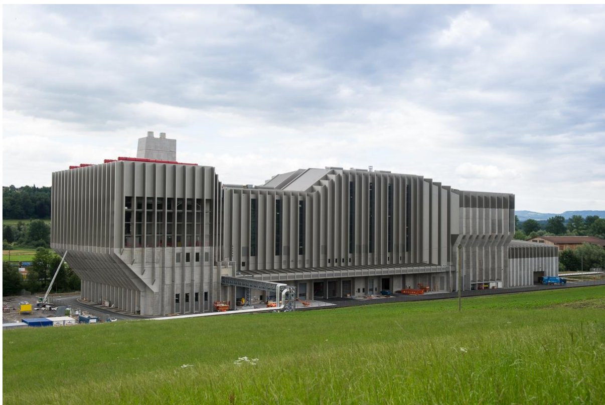
Die neue Kehrichtverbrennungsanlage der Renergia Zentralschweiz AG, die seit Januar 2015 in Betrieb ist.
