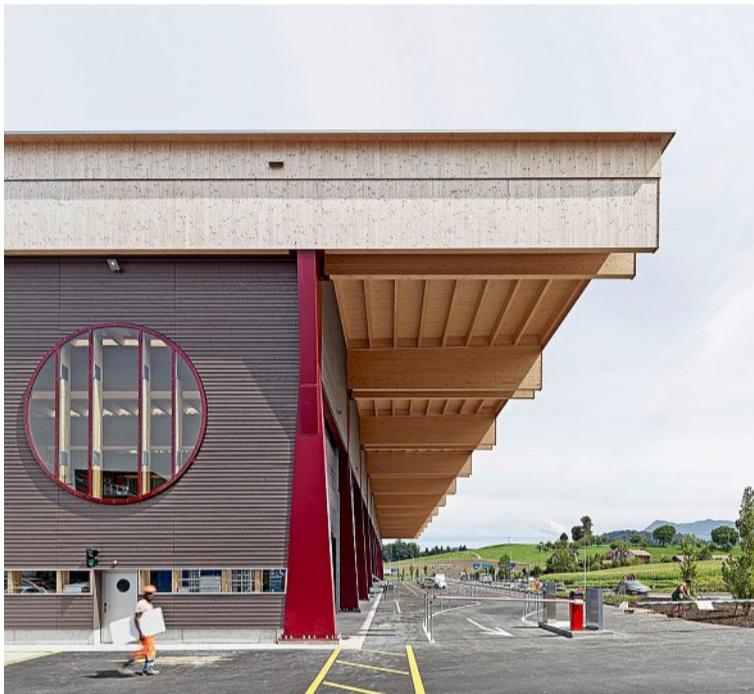
Das Fundament in der Halle bildet eine durchlaufende Betonplatte. Der 12 Meter hohe und 120 Meter lange Bau kann verkürzt oder verlängert werden
